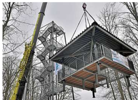
Zentimeter für Zentimeter wird die acht Tonnen schwere Aussichtsplattform des neuen Holzbergturms in 30 Meter Höhe im Zusammenspiel von Kranführer und Höhenmonteuren in die richtige Position gebracht.
